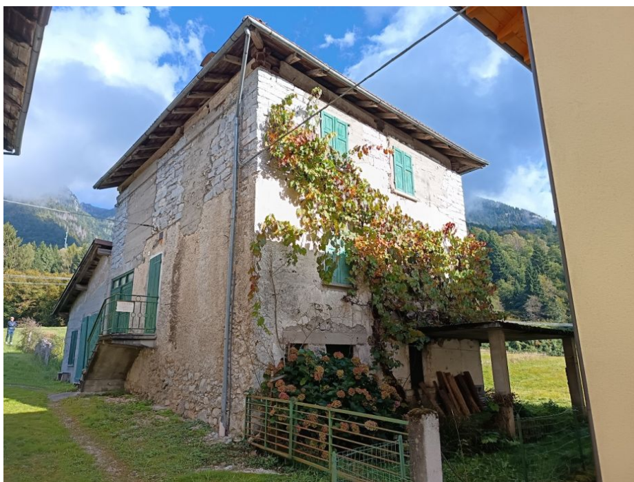
Vista esterna (sud) - p.ed. 543 - C.C. Pieve Tesino
